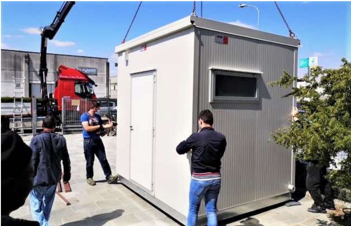
Foto Instalación de duchas en el exterior. / Beth Campo
