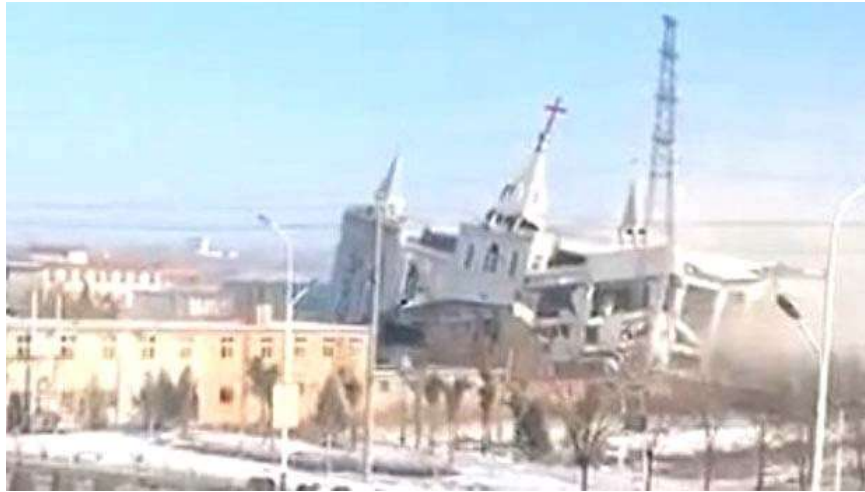
Imagen de la demolición de la iglesia. / RFA
