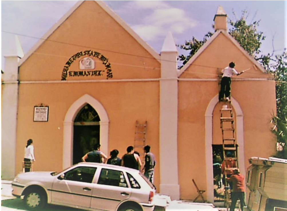
Trabajos de remozamiento de la fachada en 2006.
